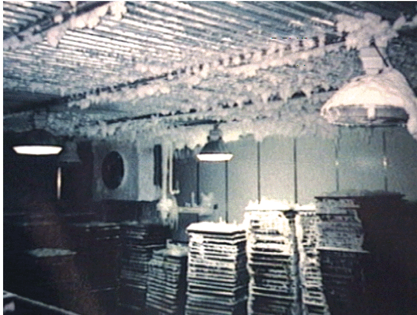
Fig. 2.55. Cameră de răcire cu bateriile givrate
