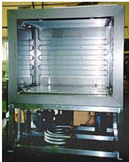
Fig. 2.46. Vaporizator de tip casnic, montat într-o cameră răcită
