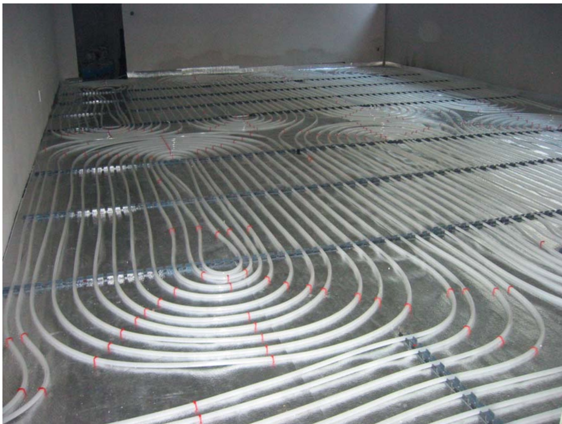
Fig.7.2.1 Modul de așezare al țevilor pentru încălzirea în pardoseală
