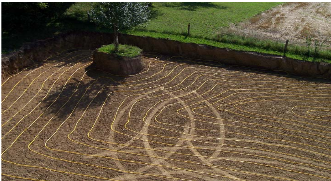
Fig7.1.5 Dispunerea țevilor unui vaporizator
