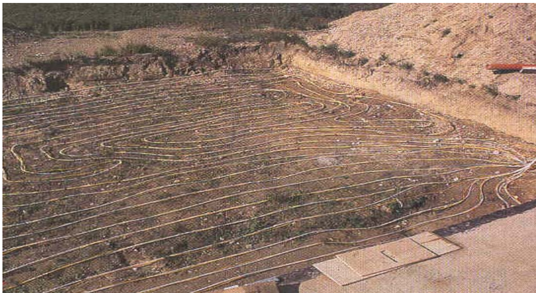
Fig.7.1.4 Dispunerea țevelor ce alcătuiesc vaporizatorul
