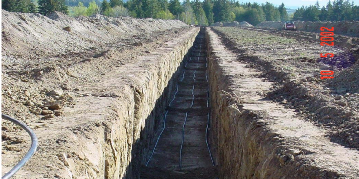
Figura 3.11 Așezarea colectorilor orizontali
