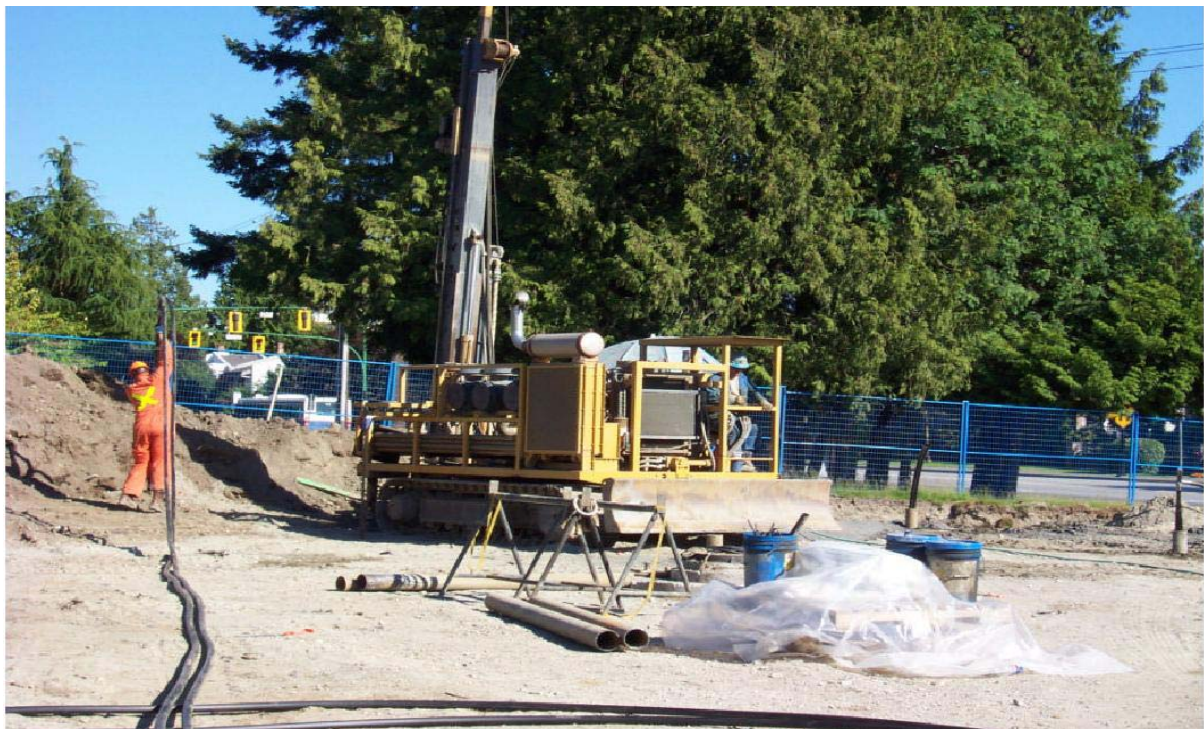
Figura 3.18 Instalații de foraj
