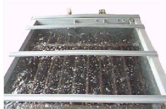
Fig. 14 Vaporizator pentru răcirea apei
