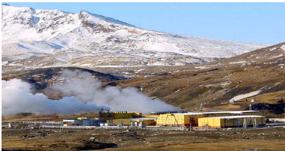
Fig. 3.5. Centrală electrică geotermală din Kamchatka, Rusia www.renewables-made-in-germany.com
