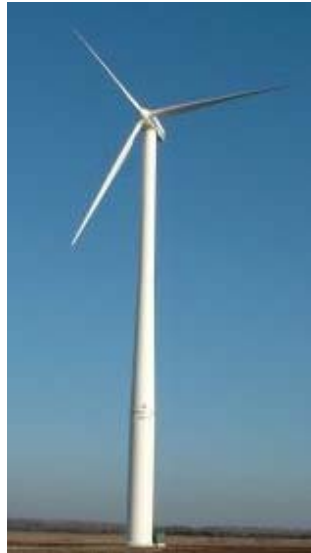
Fig. 6.3. Turbină eoliană de putere mare
