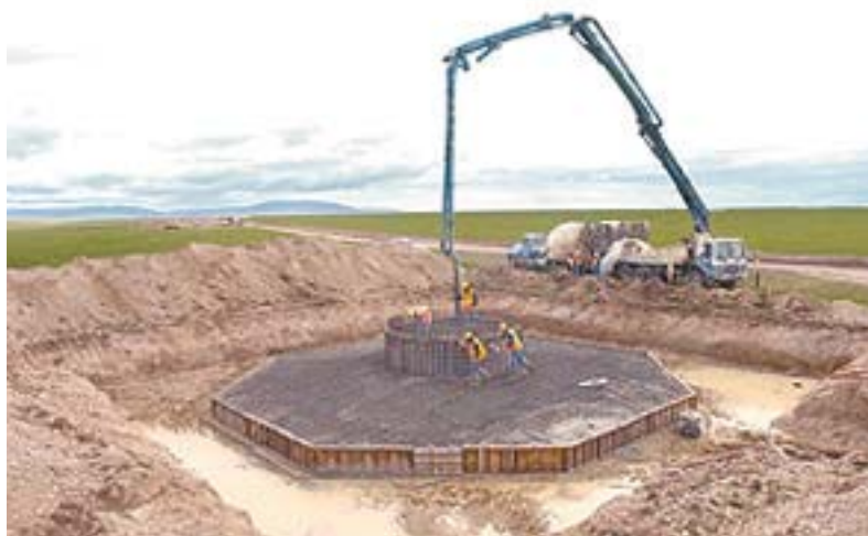
Fig. 6.13. Fundația unui pilon de turbină eoliană
