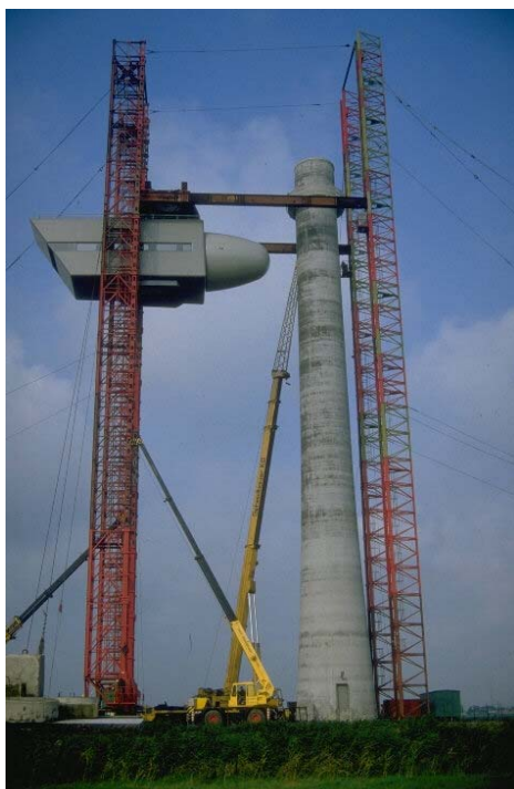
Fig. 6.12. Montajul nacelei unei turbine eoliene de mari dimensiuni
