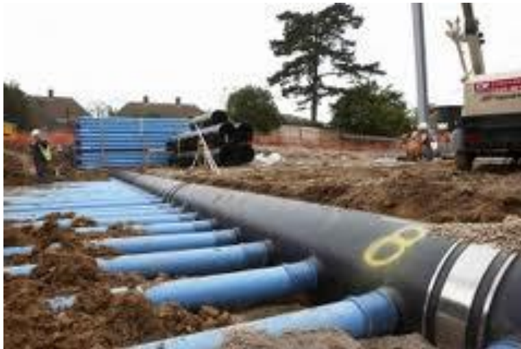
Amplasarea în sol a unui schimbător de căldură sol-aer
