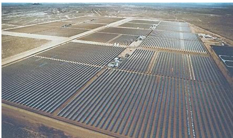
Instalație termoenergetică solară cu concentratori parabolici http://yes2renewables.files.wordpress.com/2012/08/solar-trough-farm.jpg
