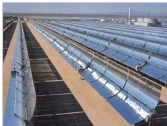
Colector solari termici cu concentratori parabolici
