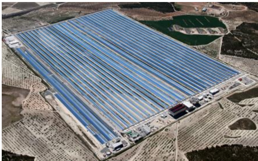
Instalația termoenergetică solară cu concentratori liniari, de lângă localitatea Puerto Errado (Spania) http://www.csp-world.com/sites/default/files/image/novatec_solar_puerto_errado_2_aerial_view_website.jpeg
