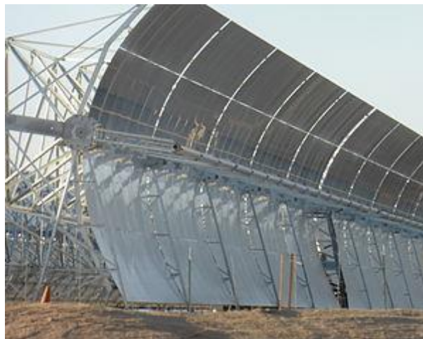
Colector solari termici cu concentratori parabolici (Harper Lake, California, USA)
