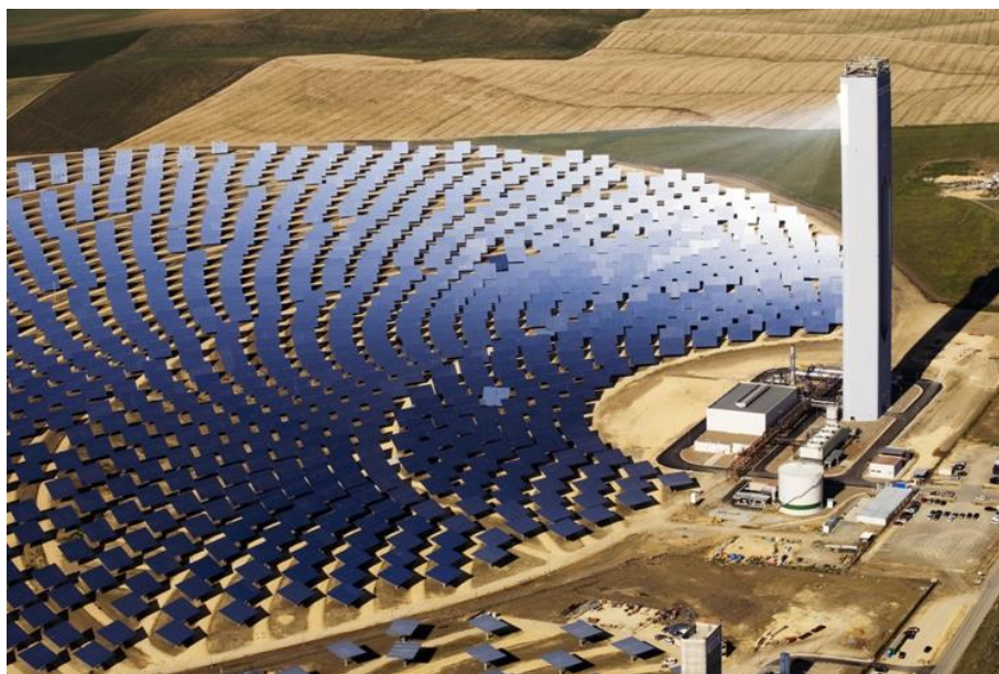
Instalație termoergetică cu turn solar (Los Angeles, USA – 110 MW)
