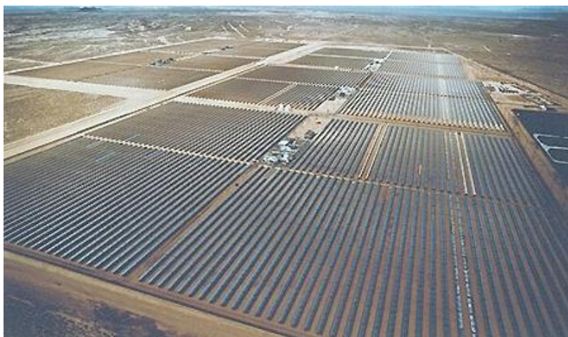
Instalație ergetică solară termică cu concentratori parabolici
