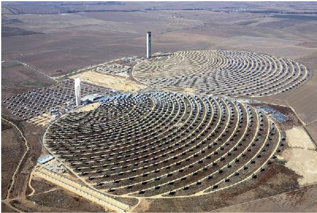
Instalație termoergetică cu turnuri solare lângă Sevilla, Spania Planta Solar 10 (PS10 – 11 MW) și Planta Solar 20 (PS20 – 20 MW) https://en.wikipedia.org/wiki/File:PS20andPS10.jpg PS 10 a fost prima instalație termoenergetică cu turn solar din lume (2007)
