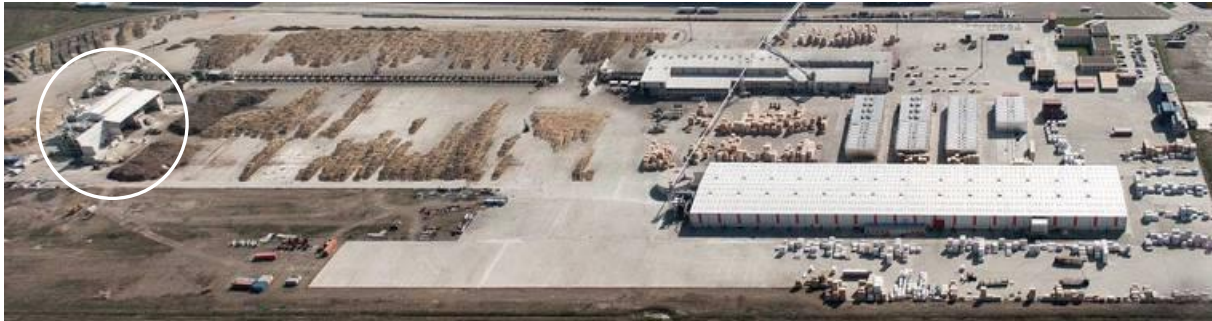
Imagine de ansamblu cu localizarea instalației de cogenerare
