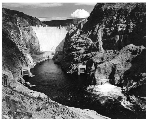
Barajul Hoover și centrala hidroelectrică (1942)
