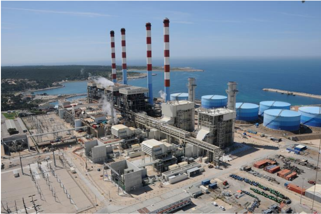
Instalație care funcționează după ciclul combinat bazat pe turbine cu gaze
