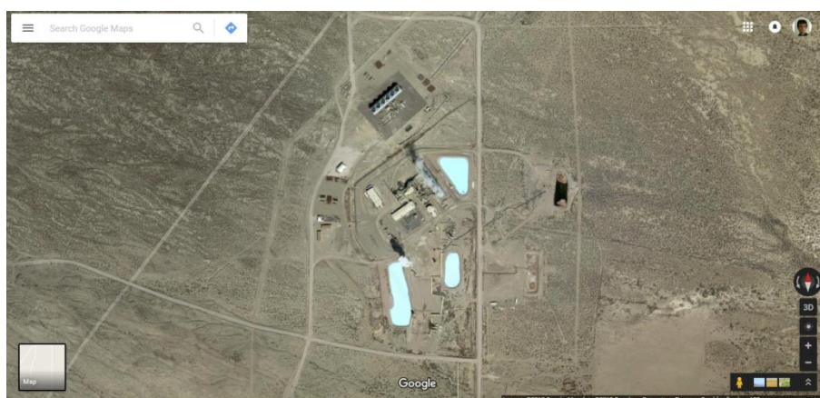
Vedere aeriană a site-ului centralei geotermale Terra-Gen Dixie Valley 67 MW (1988); (2400...3050) m adâncime; Temperatura sursei geotermale: 249 °C
