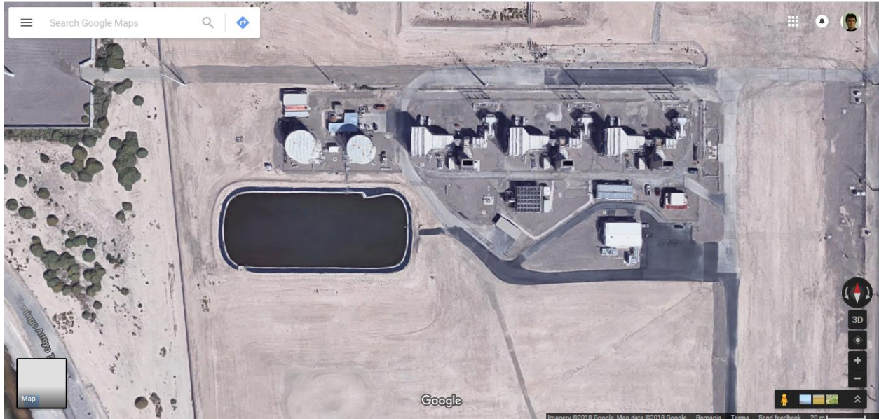
Vedere aeriană a centralei energetice Sun Peak Project
