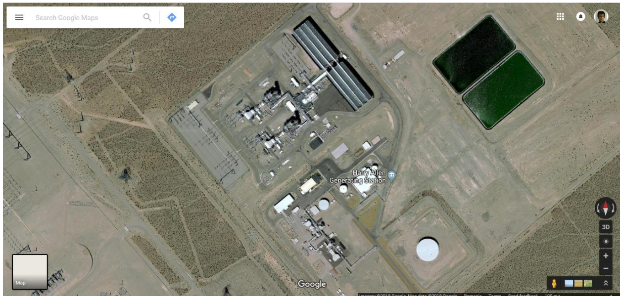
Vedere aeriană a centralei energetice Harry Allen
