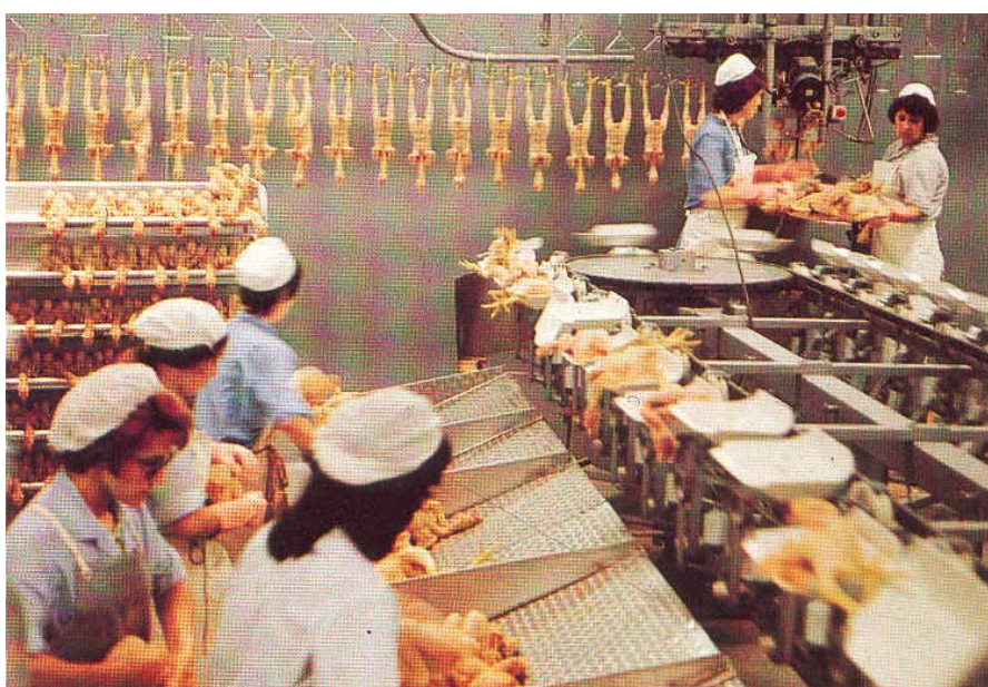
Utilizarea aerului condiționat într-o hală de prelucrarea puilor
