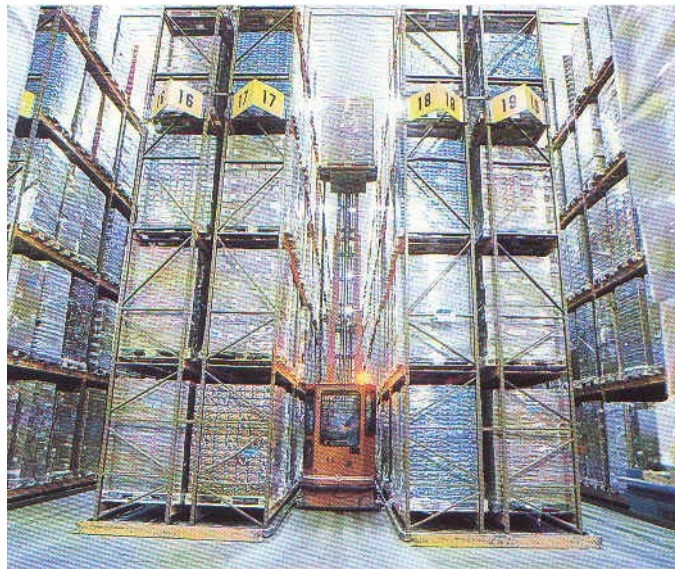
Depozit frigorific modern în care transportul este realizat cu autostivuitoare
