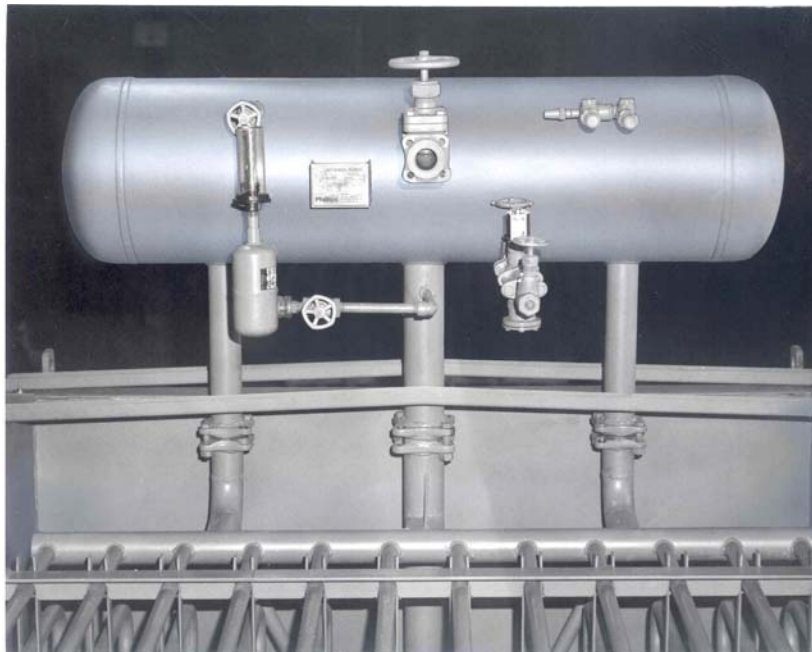
Colectorul de vapori al acumulatorului de gheață
